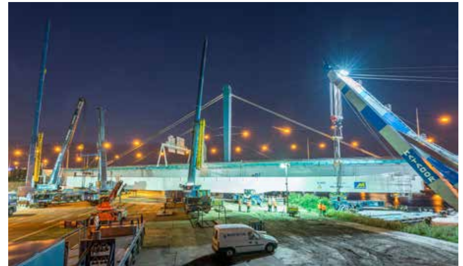
Werkzaamheden aan de Galecopperbrug
