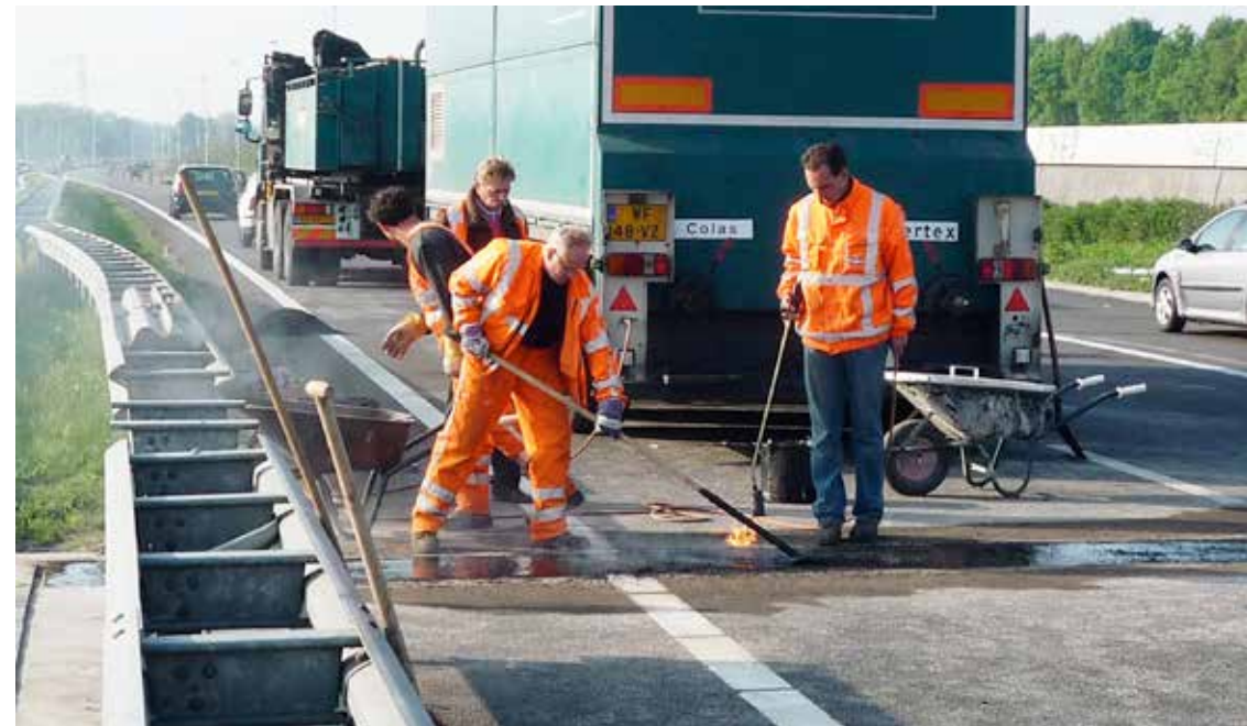
Aanleg van een voegovergang
