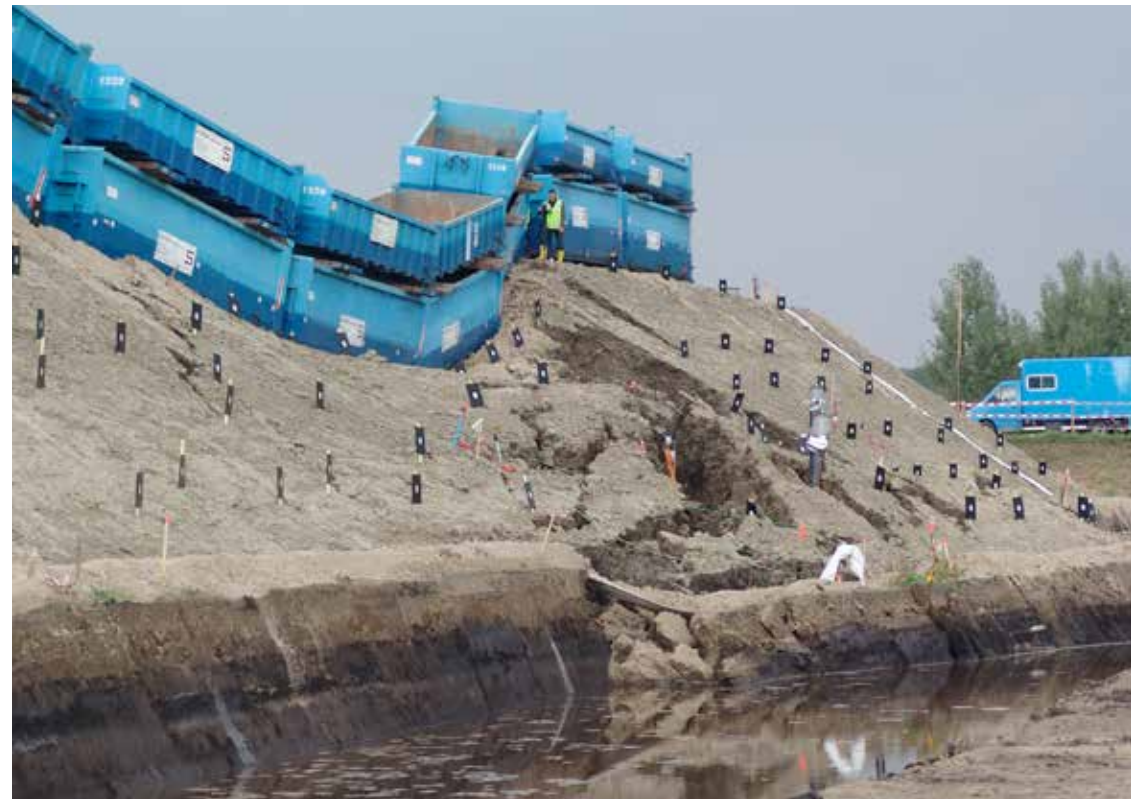
Sensoren in de Lauwersmeerdijk
