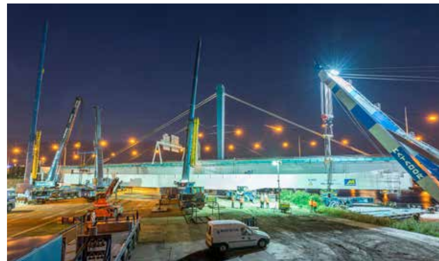
Werkzaamheden aan de Galecopperbrug
